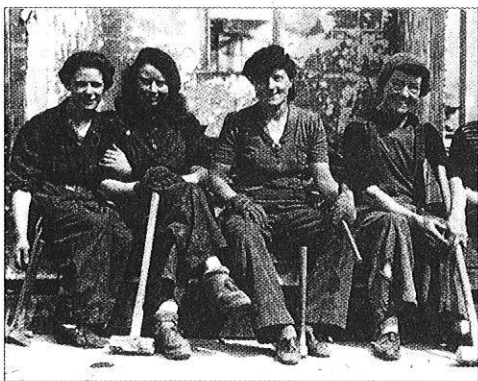
Ouvrières chargées de la démolition, prennent une pause durant le démontage d'un pont de chemin de fer devenu inutilisable suite à un bombardement.
